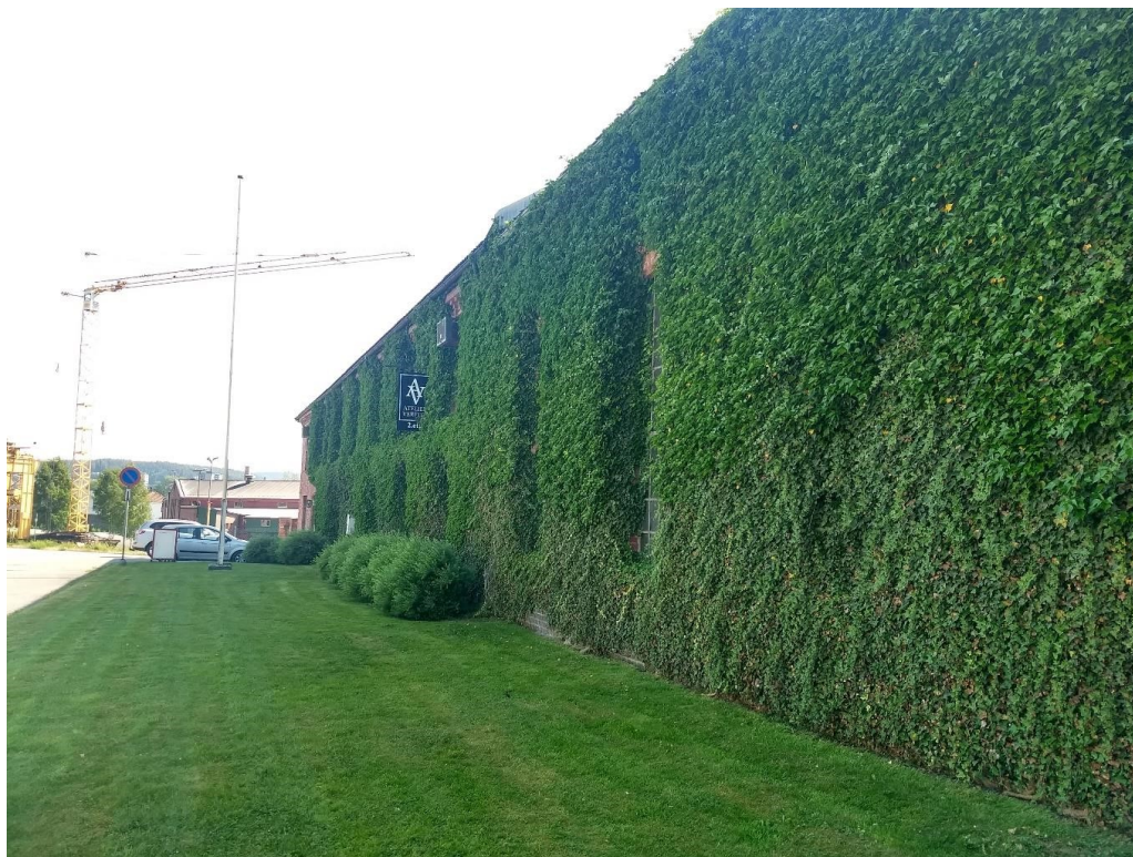
figur 6 – Villvin på nordre fasade av Kontorbygget
