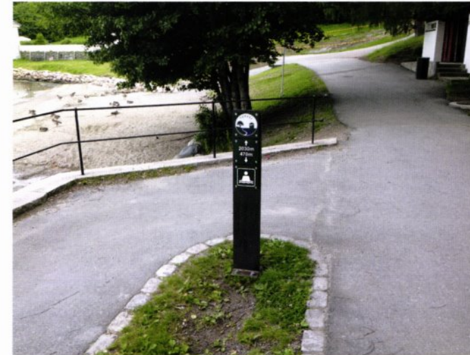
Ledende element. Bildet viser en klart avgrenset gangbane som er lett å følge for blinde og svaksynte, i tillegg til skilt som viser vei og stigningen i terrenget med opphøyd taktil informasjon. Foto: Jan Tore Lindskog, Omsorgsbygg Oslo KF.
