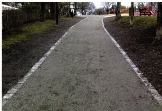
Naturlig ledelinje utendørs. Bildet viser en tydelig avgrenset gangbane med store kvadratiske kantsteiner på hver side. Dette blir en naturlig vei å følge for blinde og svaksynte. Foto: Jan Tore Lindskog, Omsorgsbygg Oslo KF.
