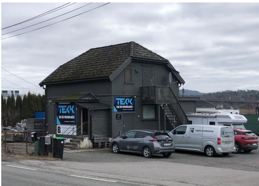
Fig. 6: Bygning i Drangedalsvegen 106
