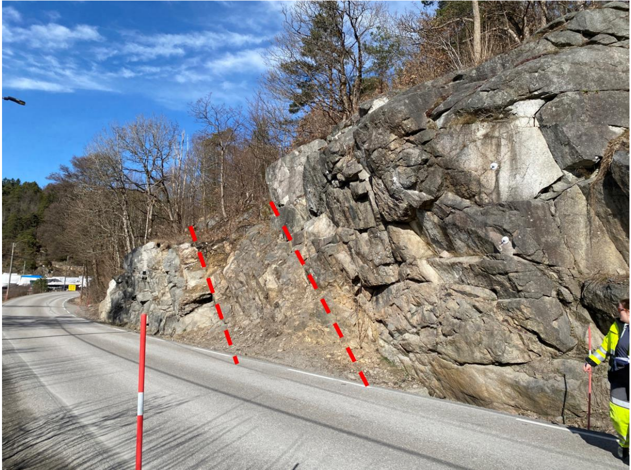
Figur 9: Observert potensiell svakhetszone/sone med tett oppsprukket bergmasse ved profil 950 og ved planlagt bergskjæring B4.
