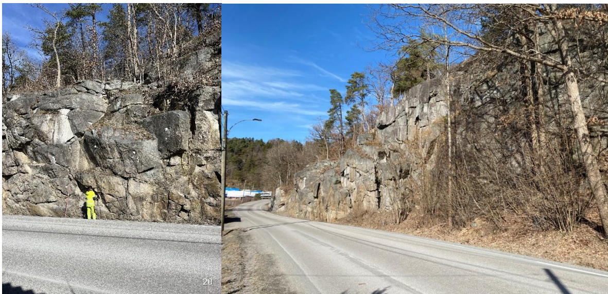
Figur 19: Bilder av eksisterende bergskjæring, fra befaring.
