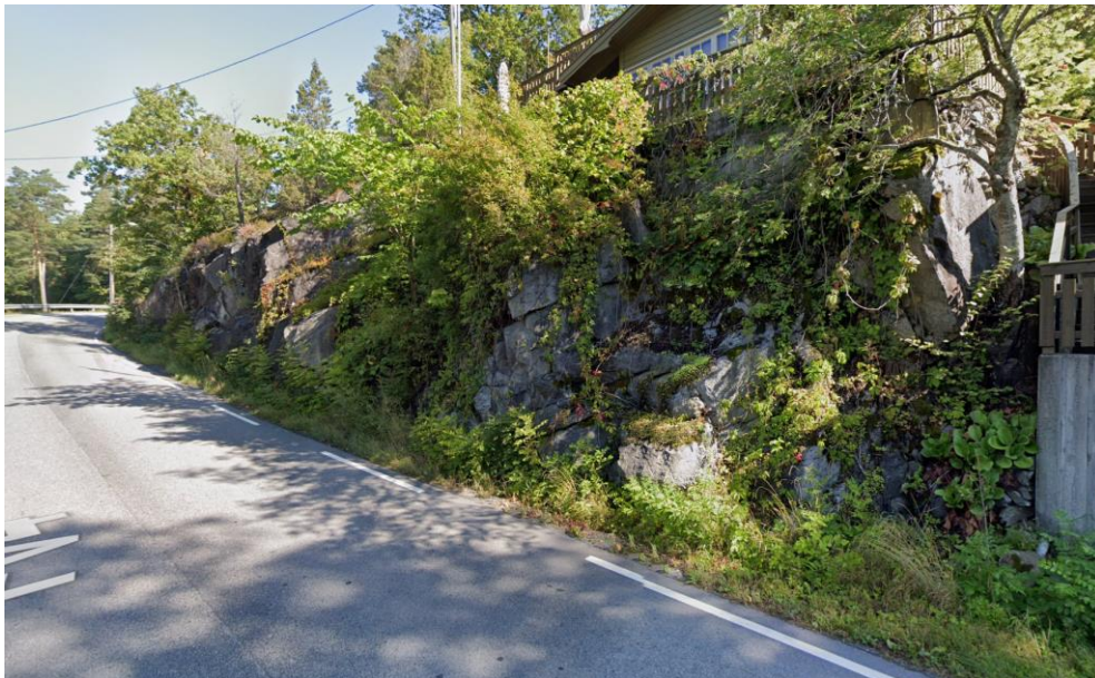
Figur 30: Bilde fra Google Street View viser eksisterende skjæring ved B7.
