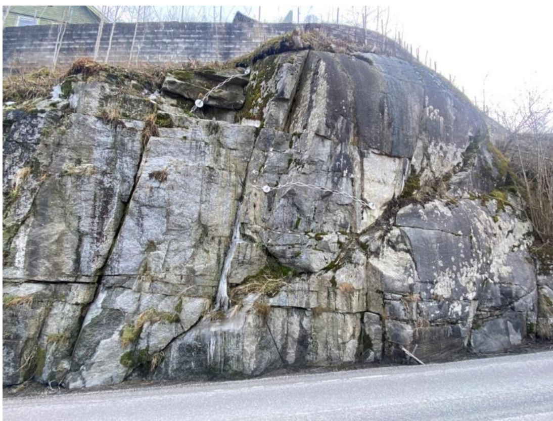
Figur 6: Eksisterende bergskjæring, ved profil 1800. Skurt berg i deler av skjæring, grovblokkig oppsprekking og noe eksisterende bergsikring.
