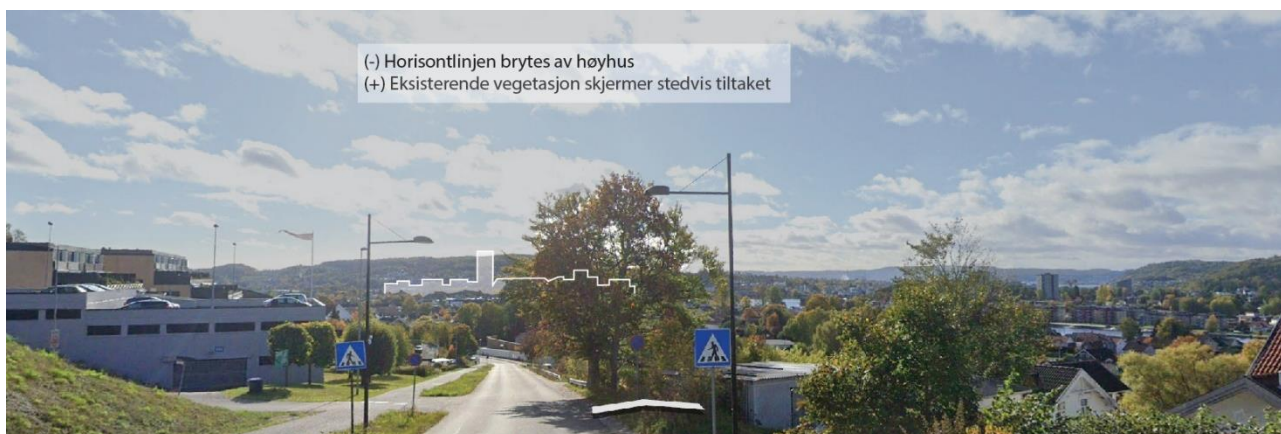
Figur 6-11: Standpunkt 7 i Breidablikkbakken, vest for Borgeåsen med sikt mot planområdet i sør. Det store volumet på ny bebyggelse vil være relativt godt synlig på grunn av sitt store volum, men Bjørntvedtåsen berøres ikke. Høyhus med 25 etasjer i BeHa-kvartalet vil bli dominerende i det store landskapsrommet. Kilde: Google Street View og modell av planforslaget.
