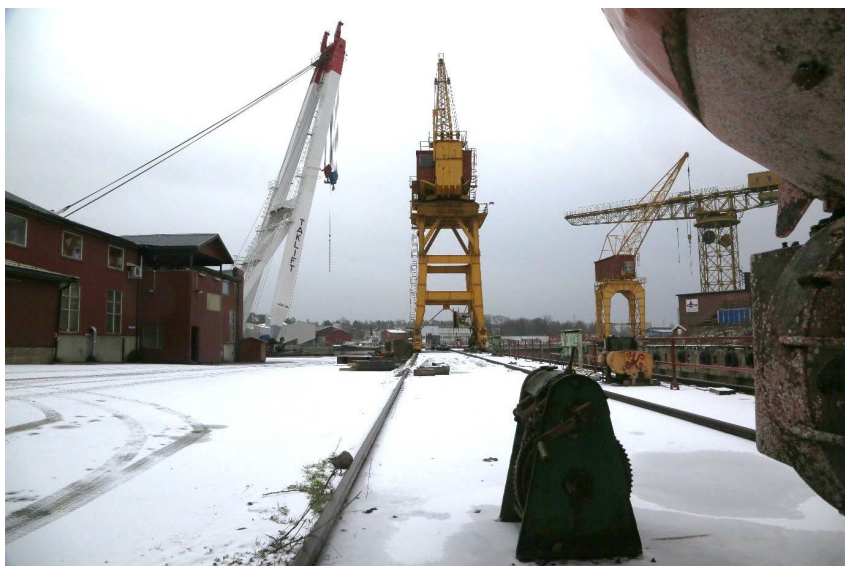
figur 19 – 25tonnskrana (t.v. for dokk) og 8tonnskrana (t.h. for dokk)
