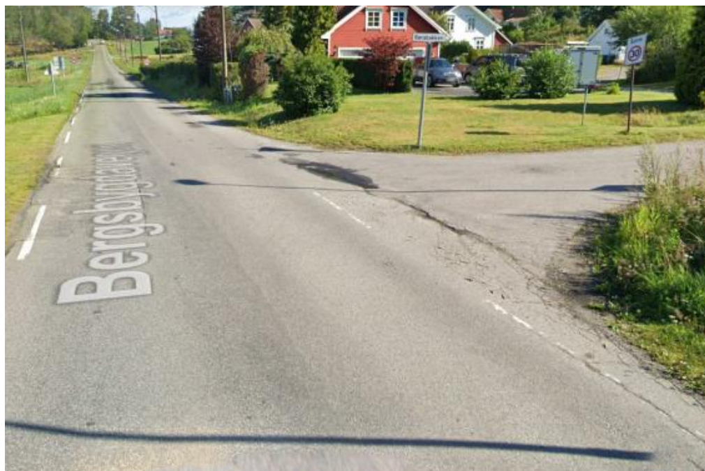
Figur 12: Bergsbygdavegen sett fra sør. Rørabakken til høyre. (Kilde: google maps)
