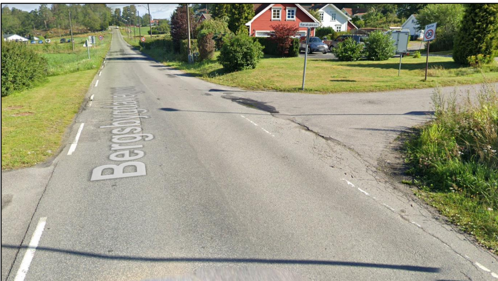
Figur 2: Bergsbygdavegen sett fra sør (kilde: Googlemaps)
