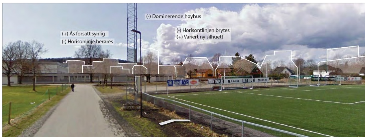
Figur 5-10: Standpunkt 5 ved Kjølnes stadion med sikt mot planområdet. Illustrasjonen viser at nesten hele silhuetten mot sørvest endres av ny bebyggelse, og horisontlinjen berøres/brytes til dels. Kilde: Google Street View og modell av planforslaget.
