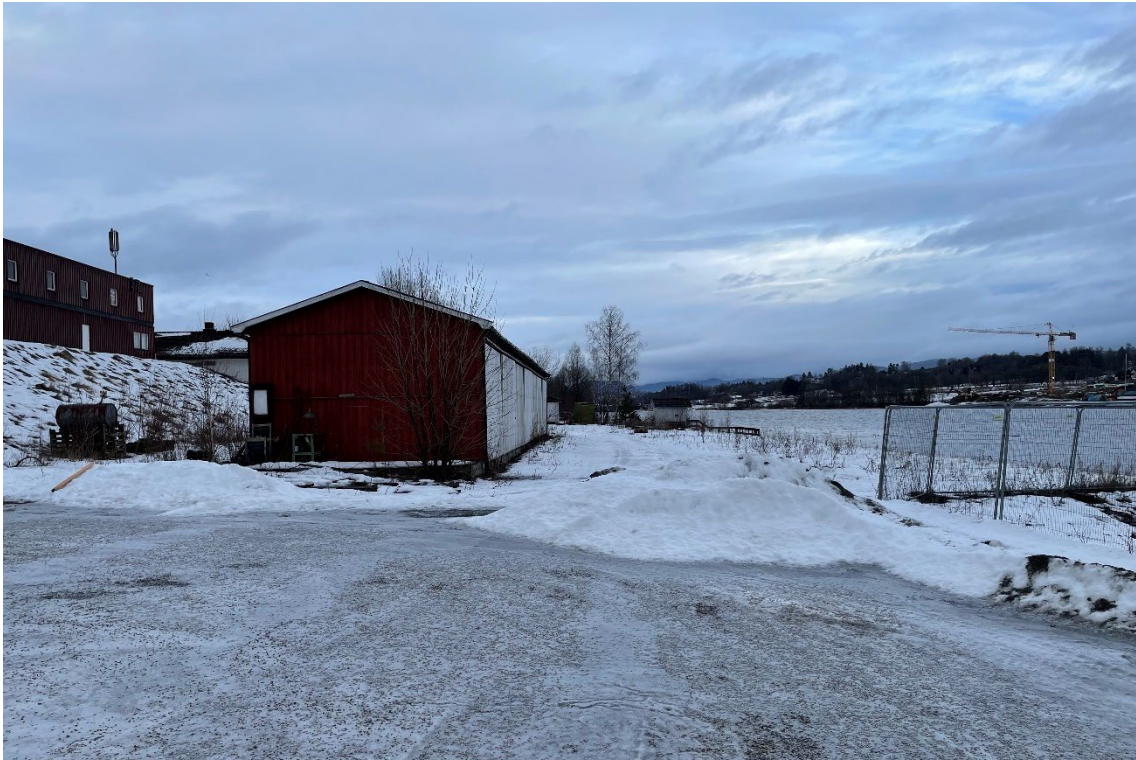
Figur 11: Foto viser terrengforskjellene som er på tomte som utgjør ca 5 meter. Sett fra sørøst.
