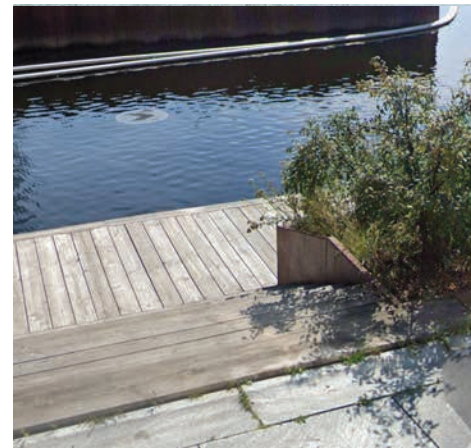
Impregnert treverk i dekke / trinn og plante kasser i cortenstål. Bispevika Oslo.
