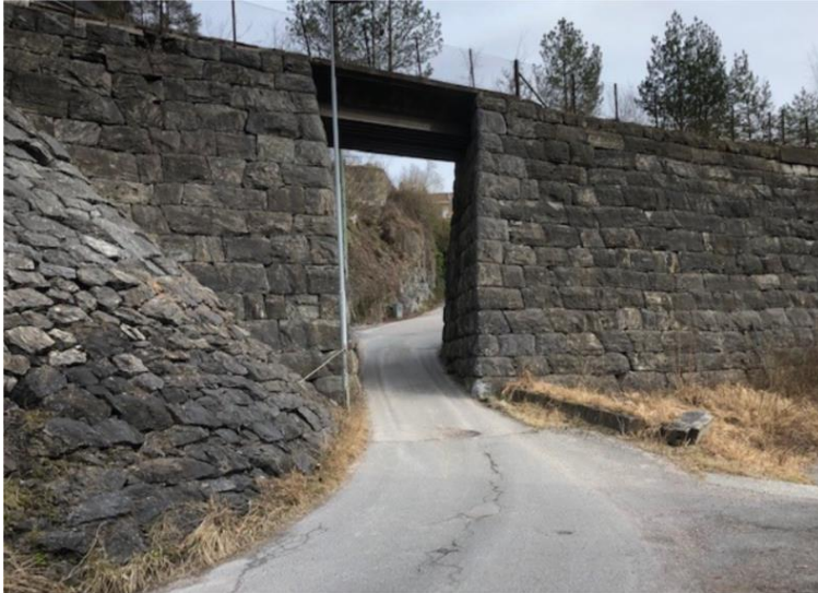
Fig. 8: Foto av jernbanemur ved Trosvikvegen
