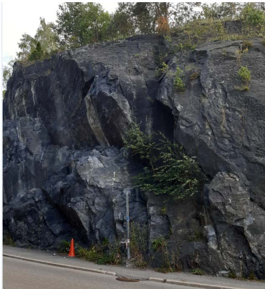
Figur 6. Foto inn mot høy skjæring i innersvingen. Det er ikke synlig sikring fra gatenivå, men vanskelige fotoforhold med sterk sol og skygge i skjæringen, gjør at evt. sikring kan være vanskelig å se.
