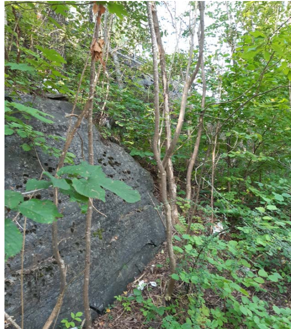
Figur 9a og b. Berg i foten av dagens vegfylling. Fotoposisjon og vinkel for foto b er vist i kartutsnittet i figur a). Det vil trolig være behov for sikring av bergfundament under framtidig mur.
