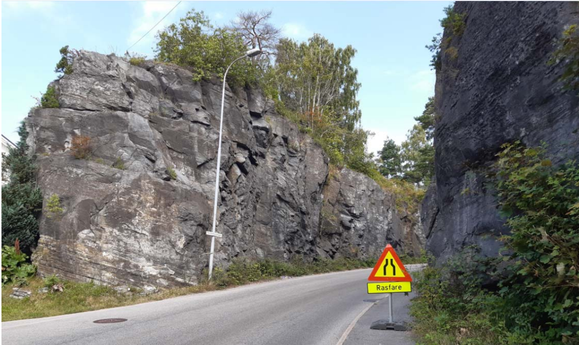
Figur 5. Foto opp Torskebergvegen. Legg merke til skilt «rasfare» i det smale fortauet. Berget i yttersvingen er mer oppsprukket enn i innersvingen. I venstre billedkant skimtes gavlvegg for tilbygg i Strømtangveien 10. Se også foto 13.
