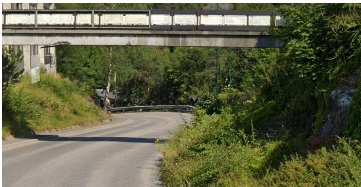
Figur 7. Det er stor nok avstand mellom vei og nordre brokar på gangbrua til at det er plass til 2 m utvidelse.
