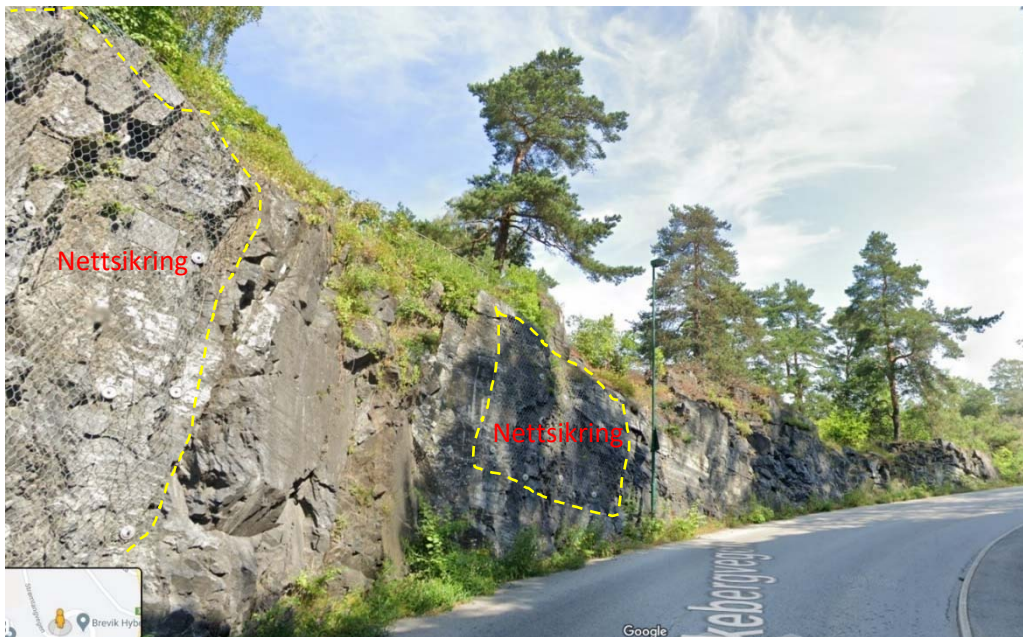
Figur 11. Eksisterende skjæring i yttersving sett oppover veien. Google maps, august 2020. Legg merke til utført nettsikring. Gatebelysning må demonteres og retableres etter berguttak.
