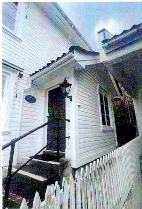
Nærbilde av inngangspartiet på langveggen mot vest. 20 -25 % av arealet på nedre plan vil tilhøre hovedleiligheten.
