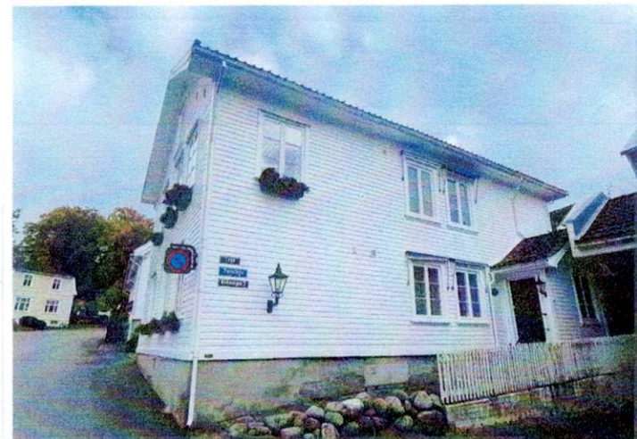
Langfasaden mot vest sett fra Kirkevegen. Vi ser inngangspartiet inn til trapperommet opp til øvre plan.
