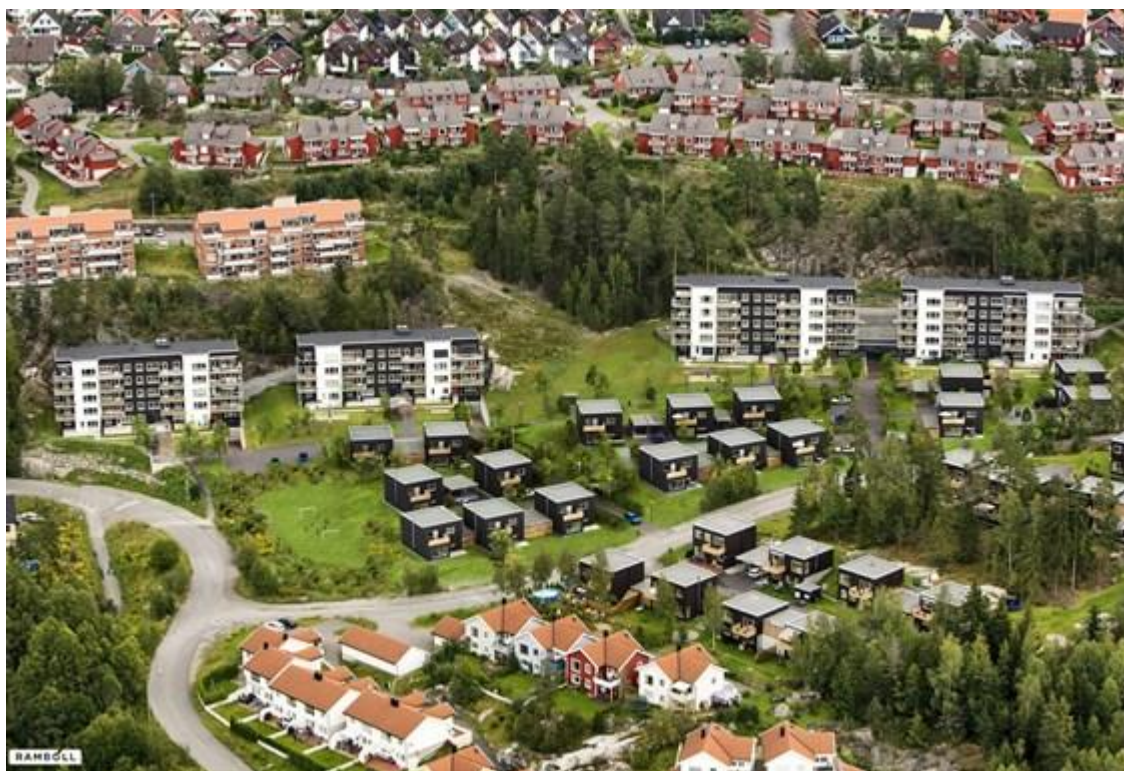
Områder med ensartet uttrykk, men med et uttrykk som er markert forskjellig fra naboområdene mhp byggehøyder, takform og fasadeuttrykk. Mortensrud, Oslo
