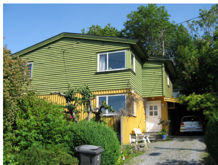
Funkishus i Haraldsgate, Herøya. Typisk for perioden både i form av todelt fasadebekledning og tidsriktig fargebruk.
