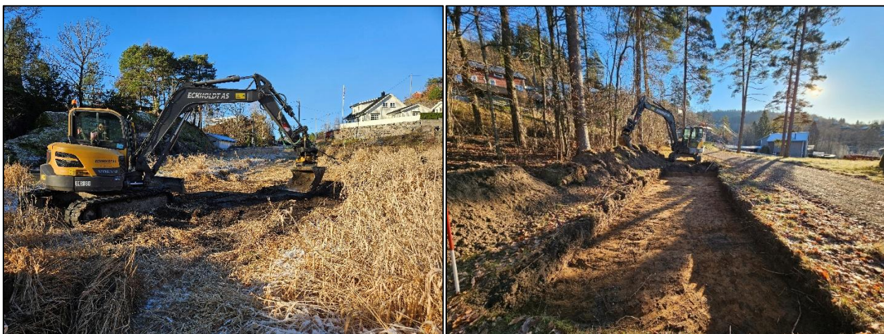
Figur 6. T.v.: Igjenfylling av sjakt 2 i Døvika, gbnr 42/1, sett mot NV. T.h.: avdekning av sjakt 4 på furumoen i Vissevåg, gbnr.. 39/17, sett mot S.
