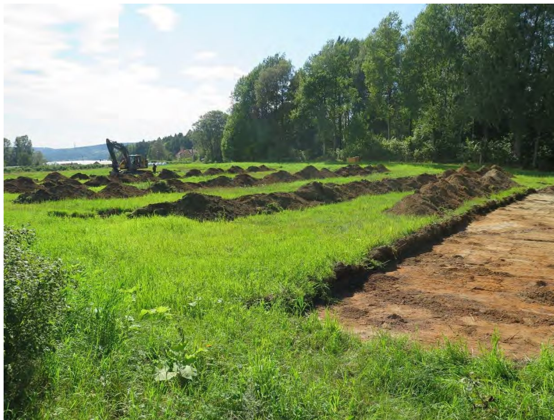
Foto 2: Oversiktsbilde av sjakteområdet
