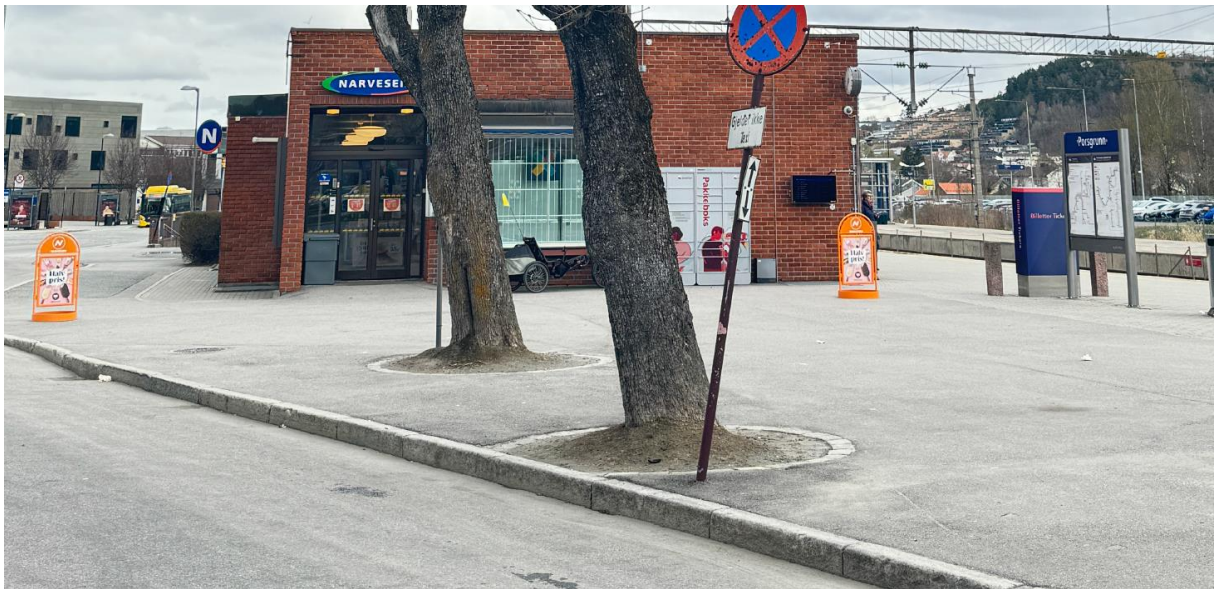
Figur 3-4 Det er asfaltert rundt de to spisslønnene. Kantstein og fundament til vei og skiltstøpler er innenfor trærnes rotsone. Kummene bakerst i bildet viser at det er infrastruktur i bakken nær trærne. Foto: Jenny Benum Lorange, 27.04.2024.
