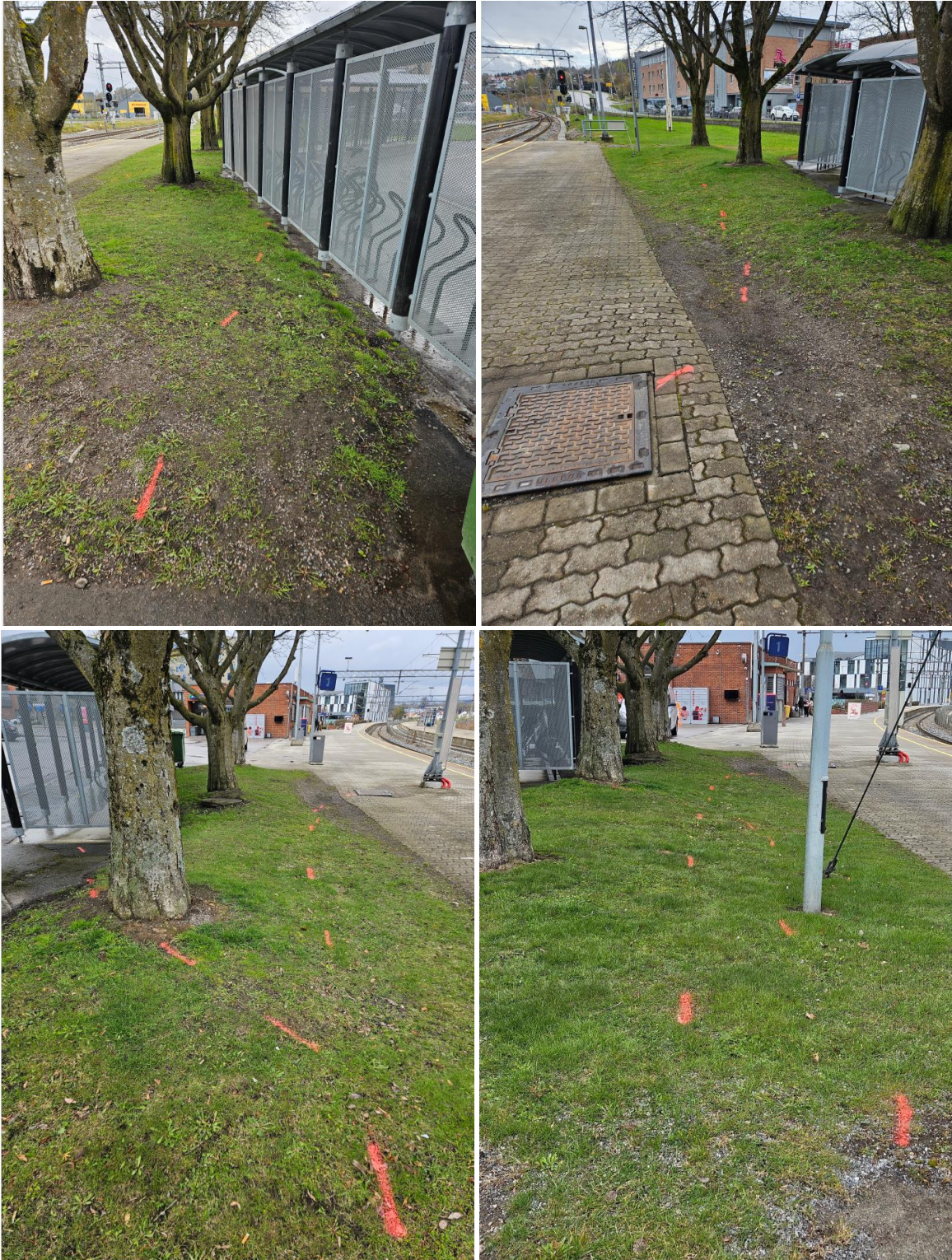
Figur 8-1 Foto fra kabelpåvisning utført av BaneNor 29.04.2024.
