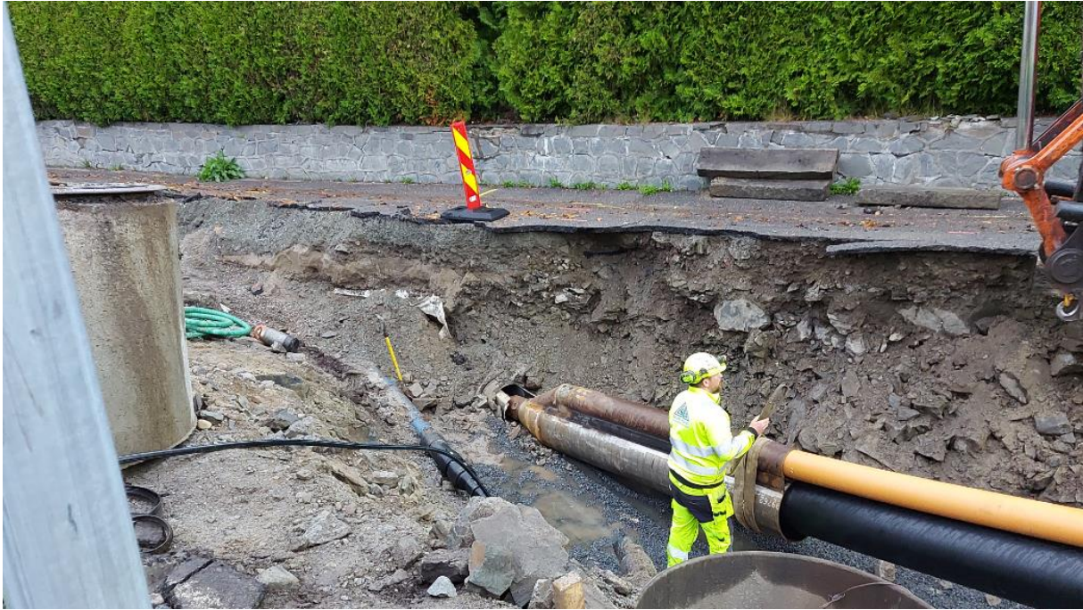
Figur 14 Dobbel utblokking. Ett gammelt rør blir til to nye
