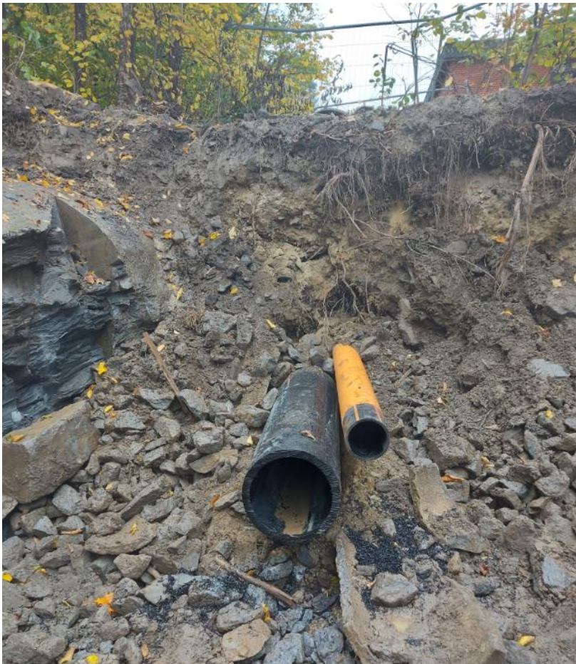
Figur 15 Det ferdige resultatet av utblokking av rør. Ett rør felles avløp på 380mm i diameter har blitt til et 200mm spillvannsrør og ett 450mm overvannsrør, helt uten graving mellom trekkegapene.
