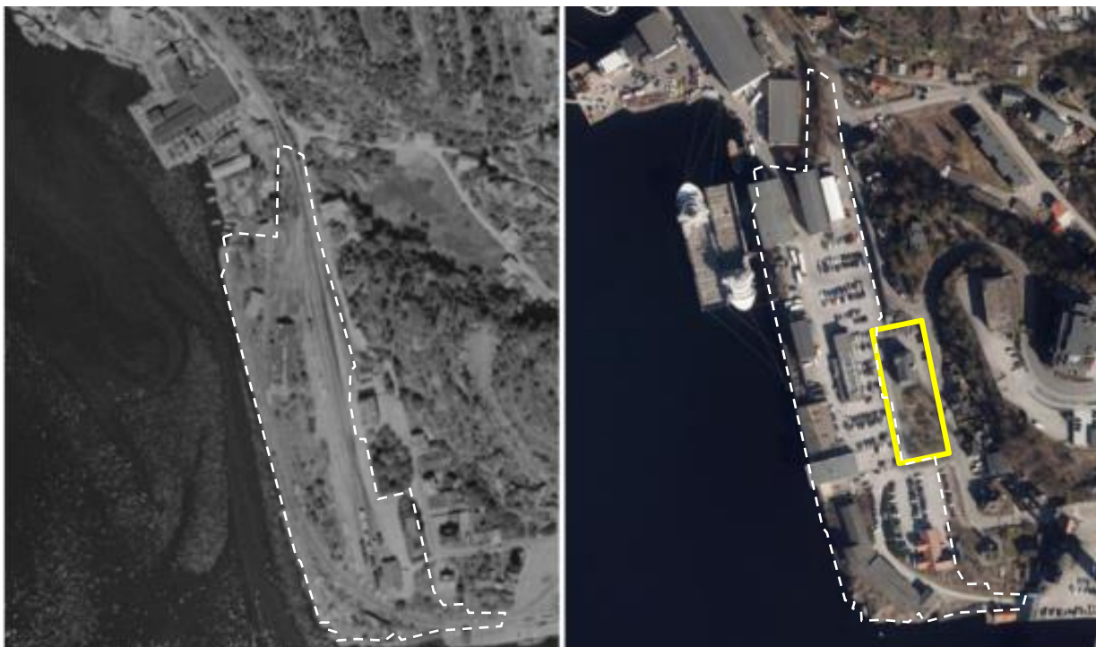
Figur 3 Flyfoto av området fra hhv. 1947 (t.v.) og 2019 (t.h.). Foto til venstre er fra en tid hvor Brevik jernbanestasjon dominerte området, mens foto til høyre viser dagens situasjon med hovedsakelig nærings- og industrivirksomhet. Gult rektangel markerer fredet området ifm. tidligere jernbanedrift. Undersøkesområdet er omtrentlig markert med hvitstiplet linje. (Fotokilde: kart.finn.no )
