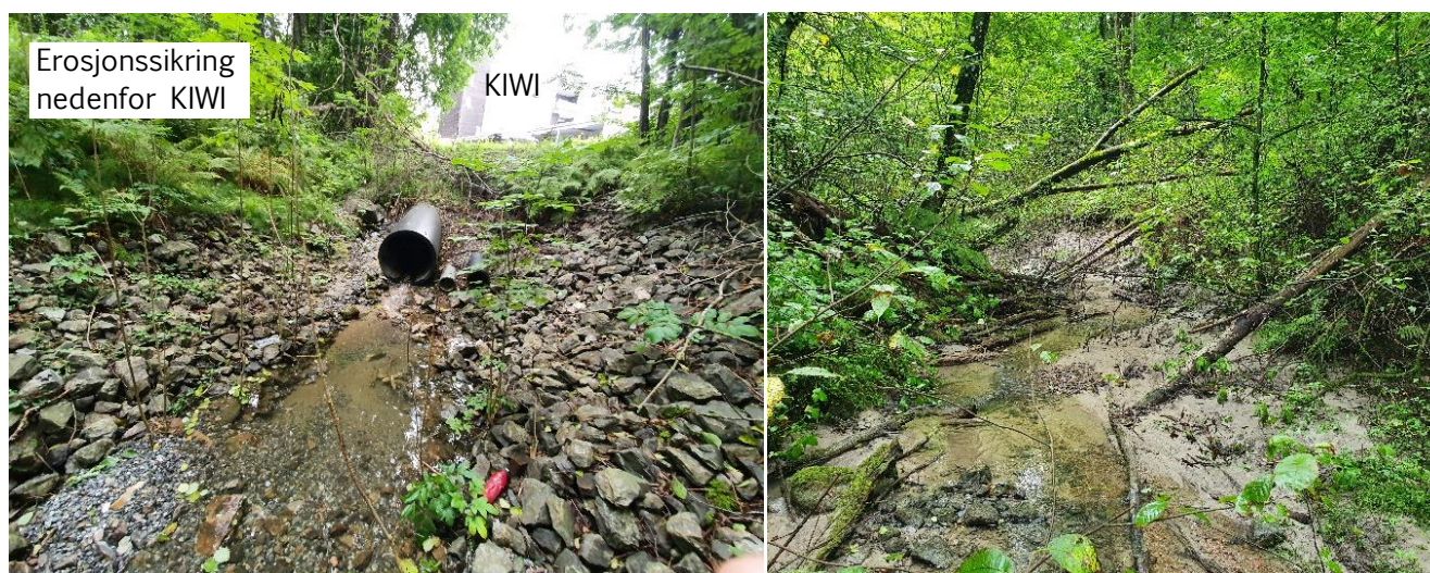
Figur 6. Bilder fra befaring den 28.07.2021
