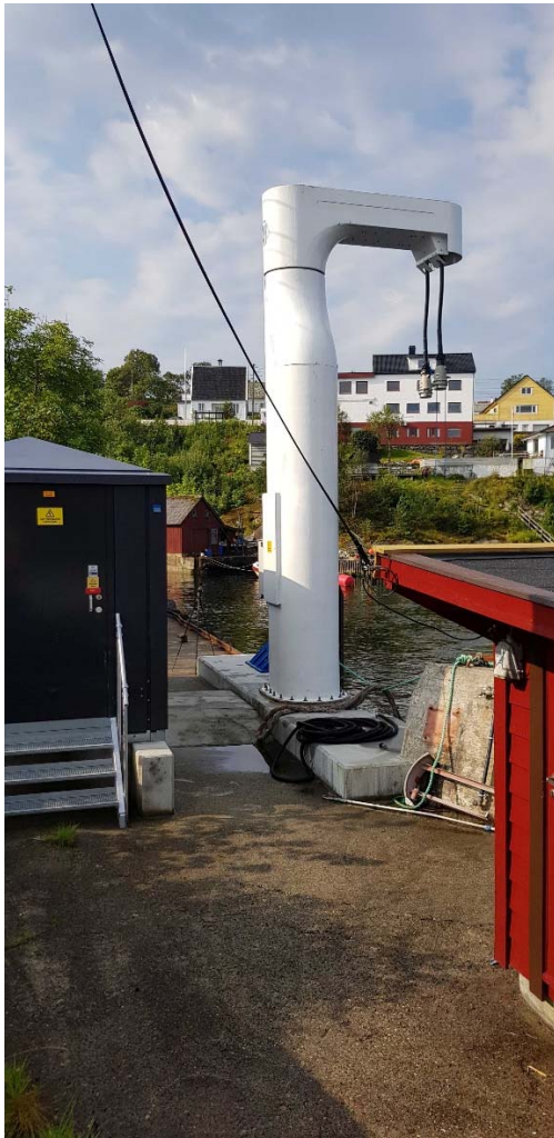
Figur 3: Foto av trafo og lådetårn på kai samt tilkoblingen om bord på hoveddekk.
