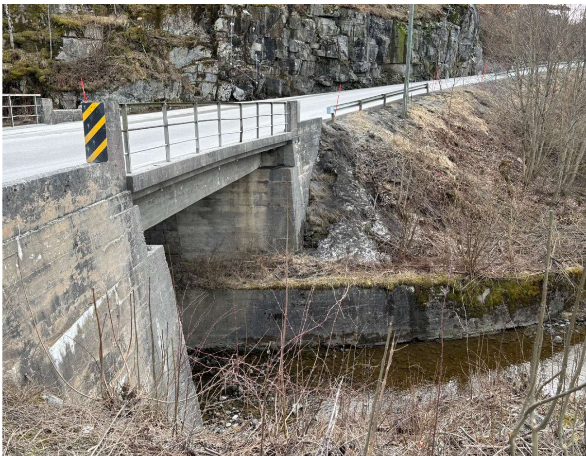
Figur 4-6 Brukonstruksjon over bekk 3 - Rutua.
