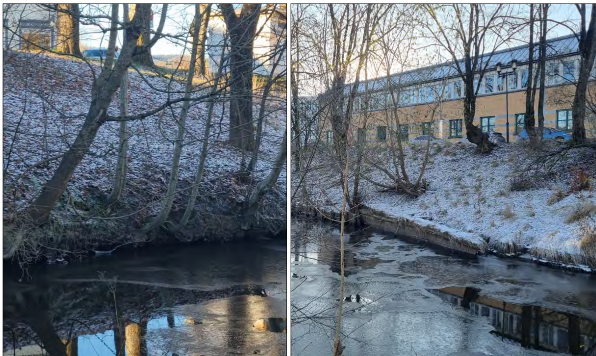
Figur 3-7: Bildet til venstre viser trær som lener seg nederst mot elven pga. erosjon. Bildet til høyre viser erosjonssikring ca. 50 m oppstrøms fra planlagt bygg
