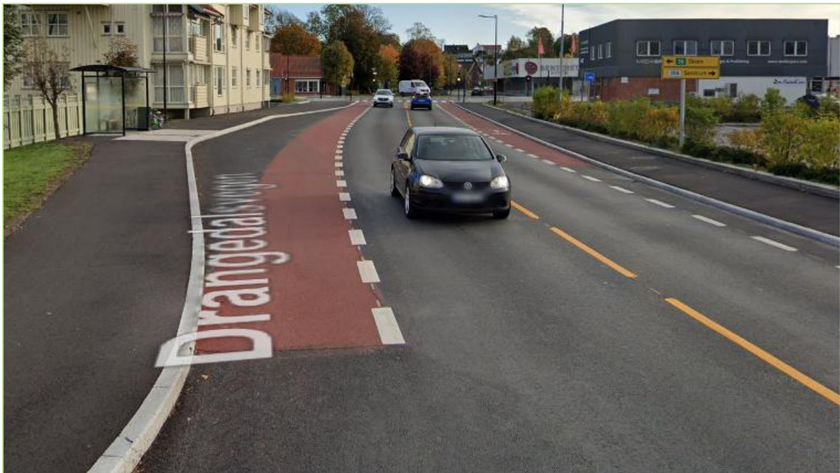
Bilde 2-6: Drangedalsvegen sett i retning nordøst tatt øst for planområdet (Google Street view)
