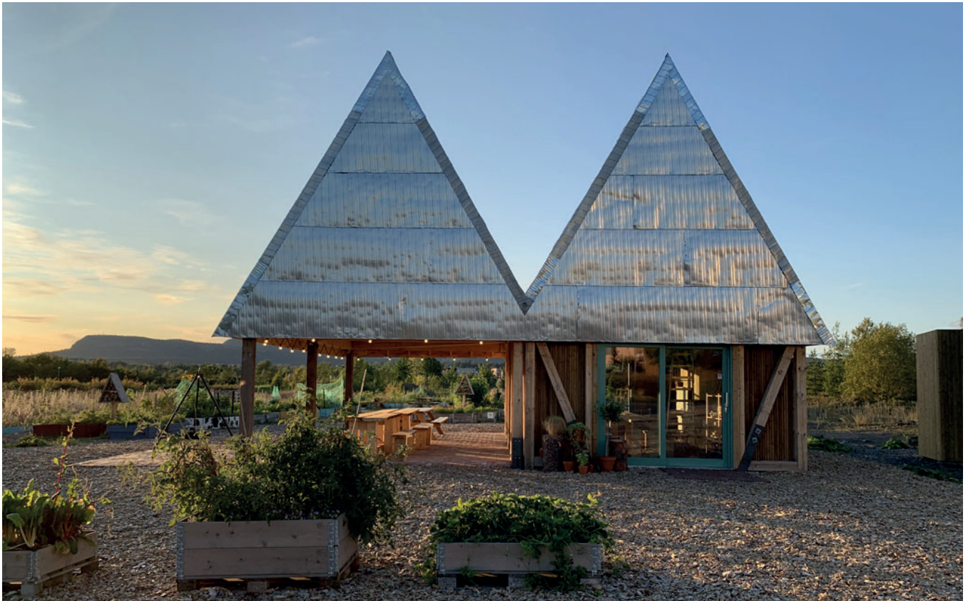
Figur 23: Et eksempel på midlertidig bygg og hage på Fornebu. Paviljongen er off-grid, det vil si strømforsyningen er med solcellepaneler, mens vann og toalettfasiliteter må bringes til stedet. Det er bygget av rest- og ombruksmaterialer. Add Arkitekter, Transborder Studio og SLA.
