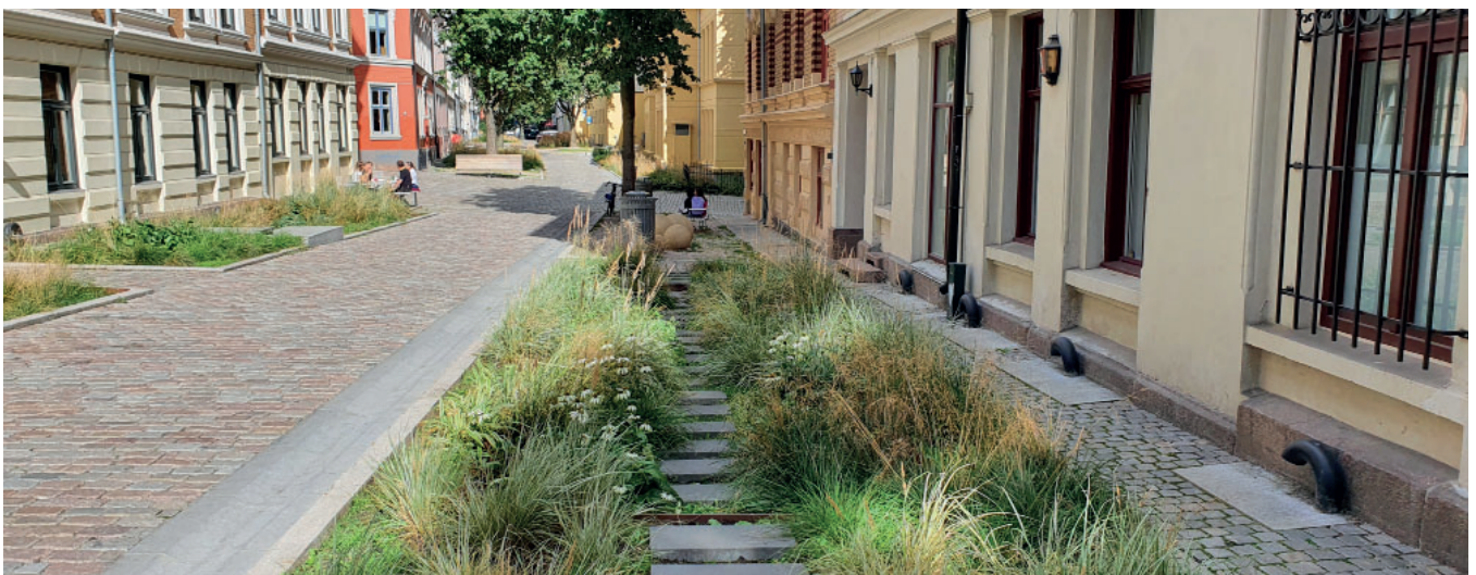
Figur 28: Overvannshåndtering i Deichmannsgate/Wilses gate av Asplan Viak viser hvordan det å benytte overflatevann som en ressurs vil være viktig i mellomrom mellom bygg og i tverrforbindelser. Her er et eksempel der takvann ledes til et regnbed i Deichmanns gate i Oslo. Foto: Arne O. Flothyl/Norconsult
