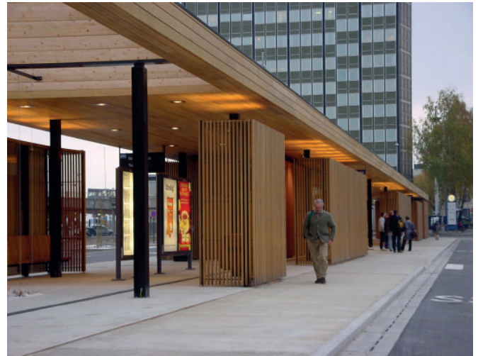
Figur 37: Illustrasjonen viser Drammen bussterminal, arkitekt: Fredrik Lund. Ventearealer til buss er utført i tre med en blanding av skjermede og åpne soner. Det er god kontakt til begge sider av stasjonen og materialbruken er lun, med gode taktile egenskaper.
