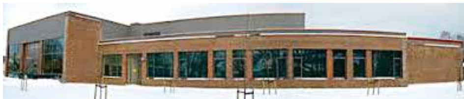
Porsgrunn videregående skole
