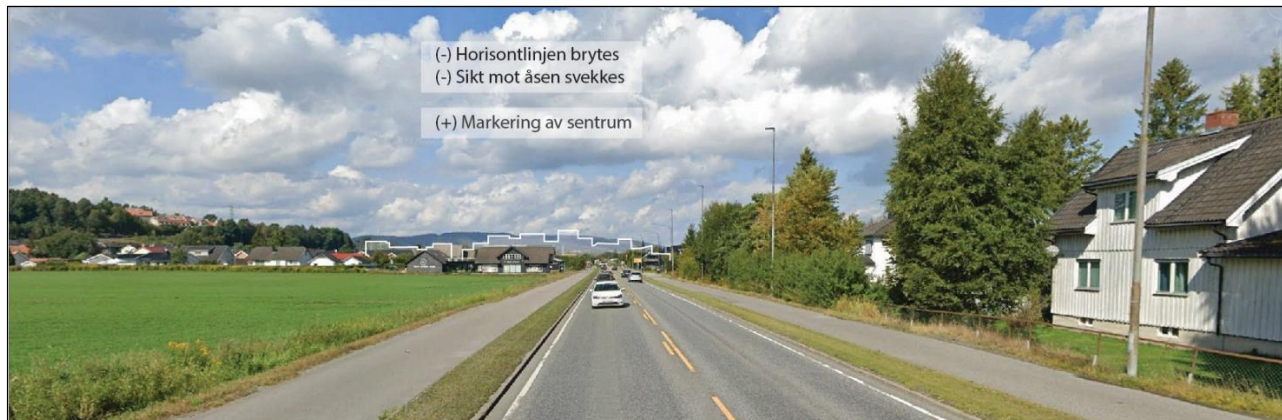
Figur 5-18: Standpunkt 11, Vallermyrvegen/fv. 32 sørøst for planområdet. Ny bebyggelse er høyere enn bebyggelsen i forkant og er derfor godt synlig på avstand, og de høyeste byggene bryter horisontlinjen mot silhuetten av åslandskapet bak. Kilde: Google Street View og modell av planforslaget.
