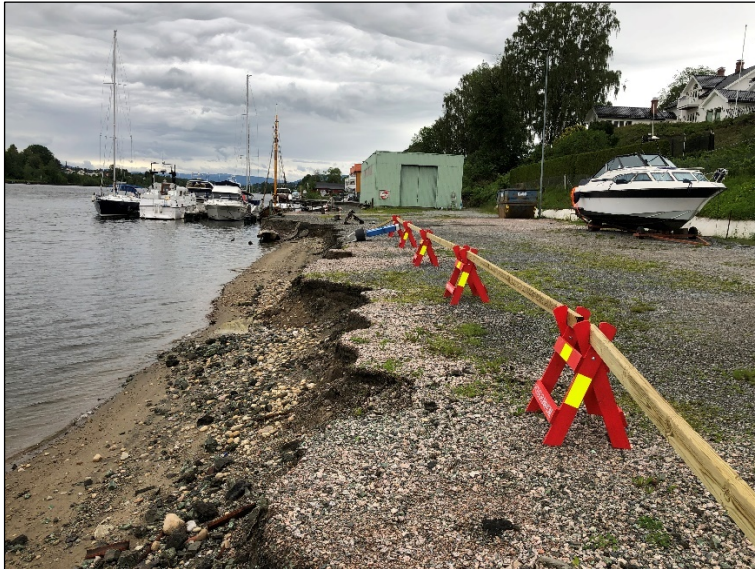
Figur 37 viser bilder av eksisterende situasjon i område 1.
