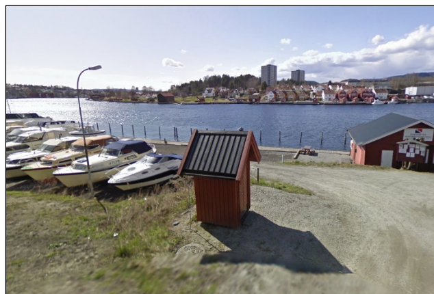
Figur 26: Pumpehus ved Porsgrunn mototbåtforening
