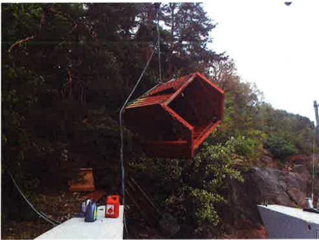
Det gamle skjærgårdstoiletet løftes bort
