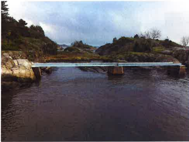
Nye fundamenter og bærebjelker på Veaholmen
