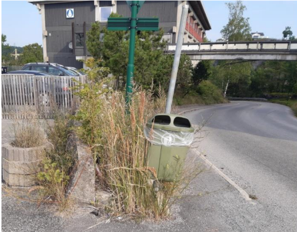
Figur 2. Foto venstre side ca. profil 55. Vegen kan utvides mot venstre før gangbro
