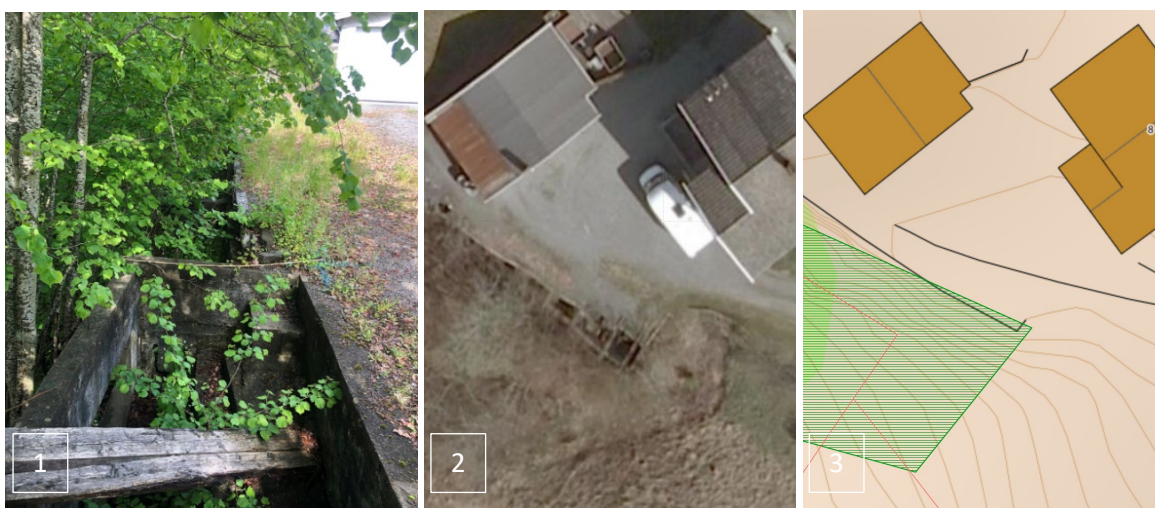
Figur 1: 1- Eksisterende murkonstruksjon, 2- Flyfoto med murkonstruksjon, 3- Avgrensning for naturtype med mur
