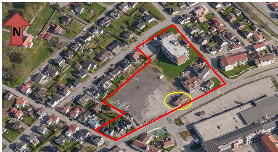
Figur 3-1 Skråfoto over planområdet fra 2018. Figuren er hentet fra Porsgrunn kommunes kartløsning [3] og planområdet er grovt avgrenset med rødt. Hus markert med gult er nå revet.
