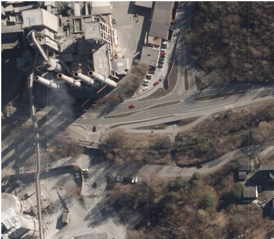
Figur 18. Kryssene ved Norcem. Med Hillsveg til venstre og kryss med Setrevegen til høyre. Nord - Heistad/Porsgrunn til venstre.
