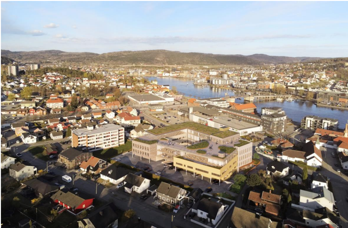
Fig. 16: Prosjektet sett fra luften mot øst; mot Porsgrunnsbrua og sentrum
