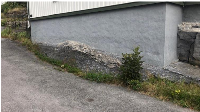
Observert fjell i dagen ved grunnmur mot vest (mot Gropkleiva)
