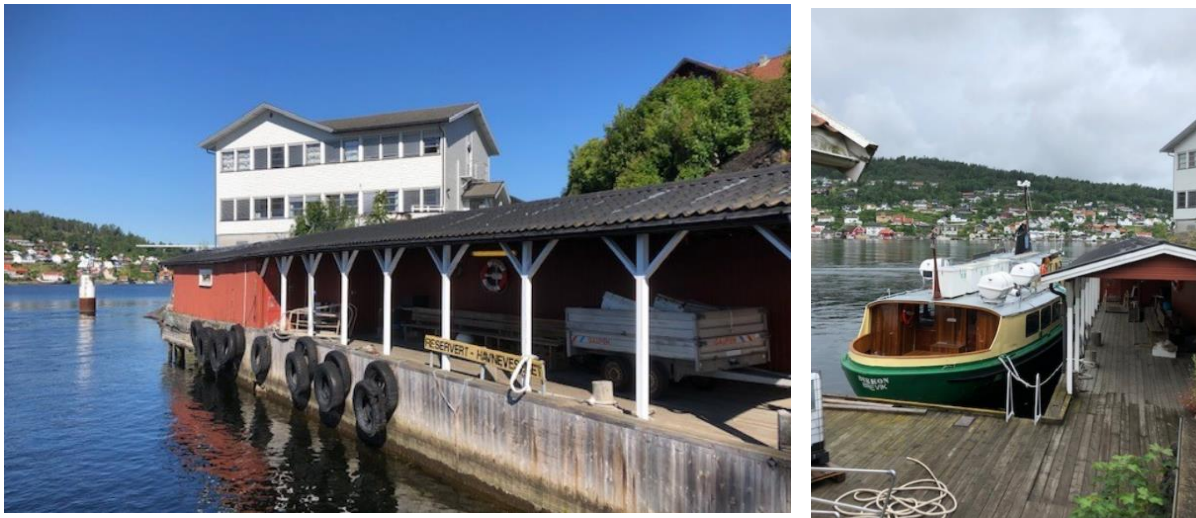
Fig: 37: Kaia hvor ferga «Dikken» ligger fortøyd
