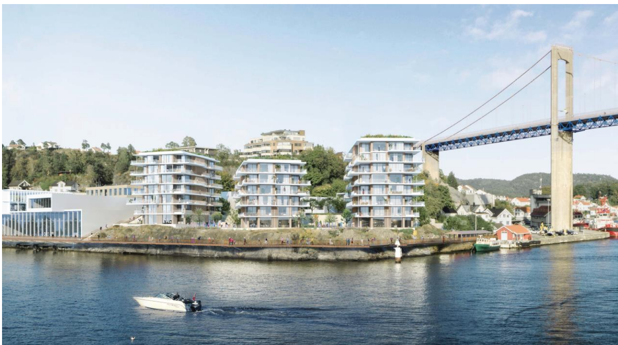
Fig. 21: 60 leiligheter med store generøse balkonger på pynten mot Strømtangen. En offentlig bryggevandring gjør sjøkanten tilgjengelig for alle.
