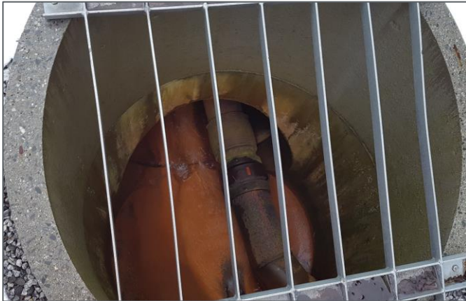
Figur 20: Foto av inntakskum til OV1000BET oppstrøms Massedeponi16. Spillvannsrøret markert i Gemini er her synlig. (Gemini).
