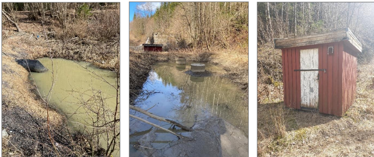
Figur 7: Basseng 1 og 2 er vist hhv. til venstre og i midten. Eksisterende rødt bygg er vist til høyre.
