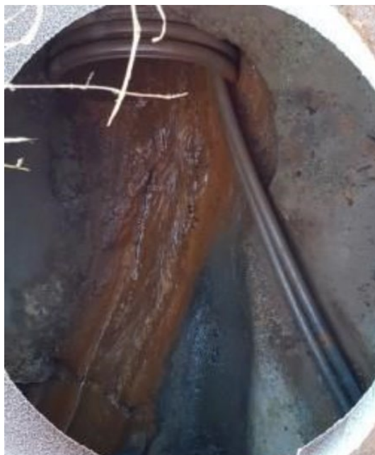
Figur 8. Kumbilde av kum 99915 i Pasadalen. Bildet viser at OV400PVC videreføres, antatt til OV1000BET. (Gemini)
