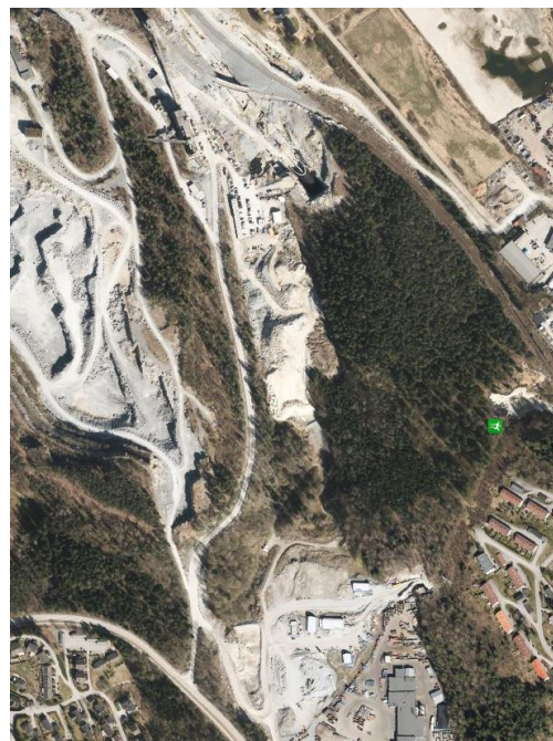
Figur 5 Flyfoto Pasadalen 2015. Nødtunellen for jernbanen er under etablering og Massedeponi16 er påbegynt. (Finn)
