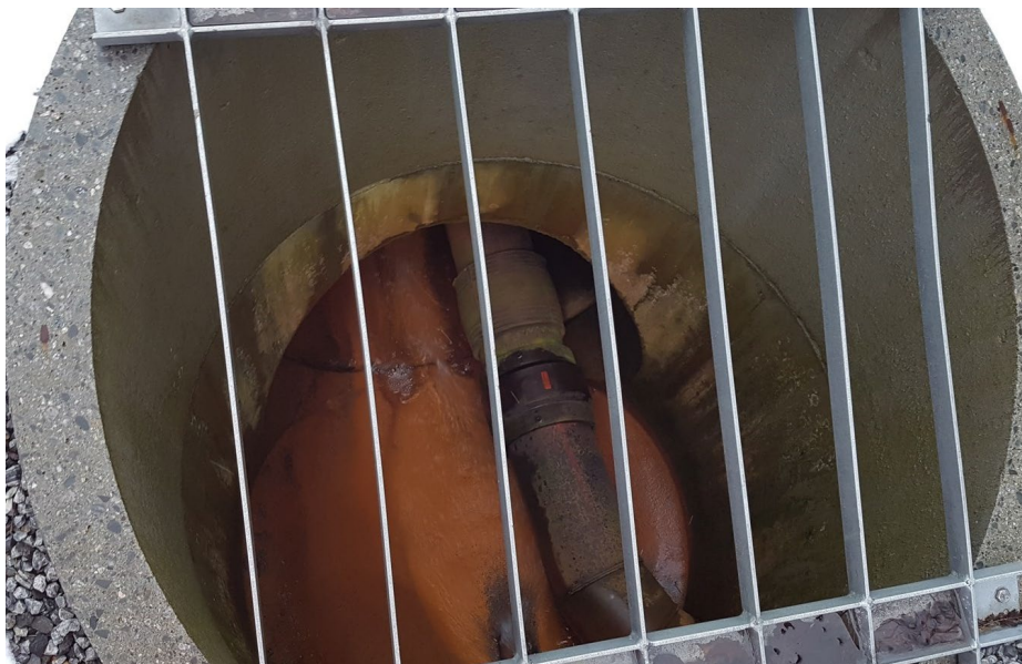
Figur 9. Foto av inntakskum (99913) til OV1000BET oppstrøms Massedeponi16. Spillvannsrøret markert i Gemini er her synlig. (Gemini)
