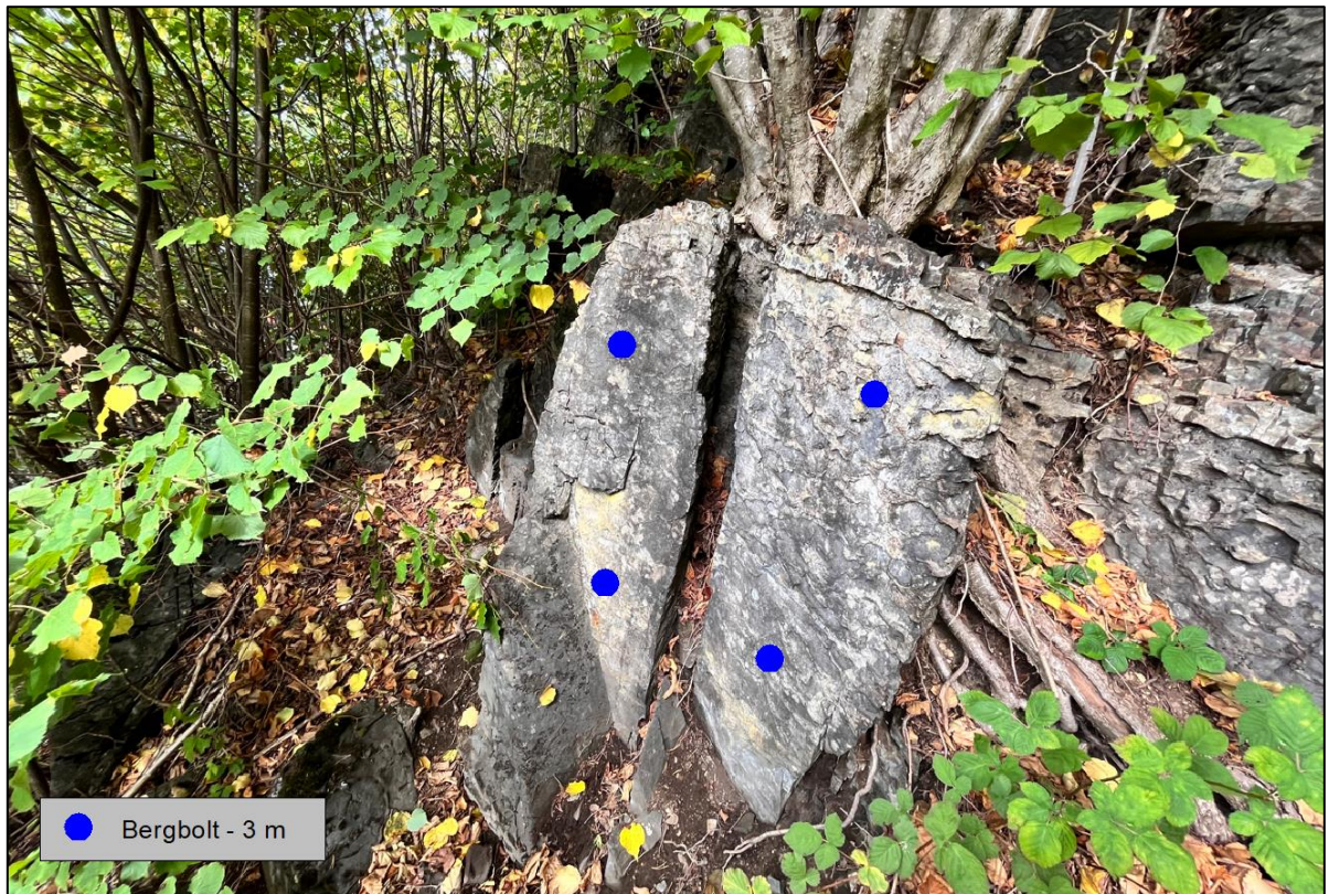
Figur 8. Sikring med bergbolter - fareområde sør.
