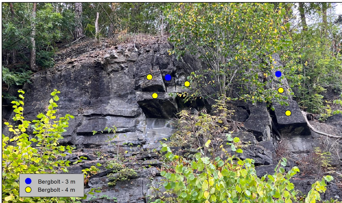
Figur 10. Sikring med bergbolter - fareområde sør.
