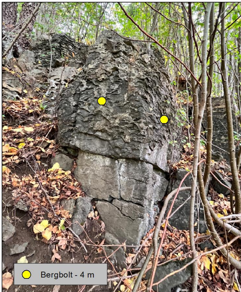
Figur 7. Sikring med bergbolter - fareområde sør.
