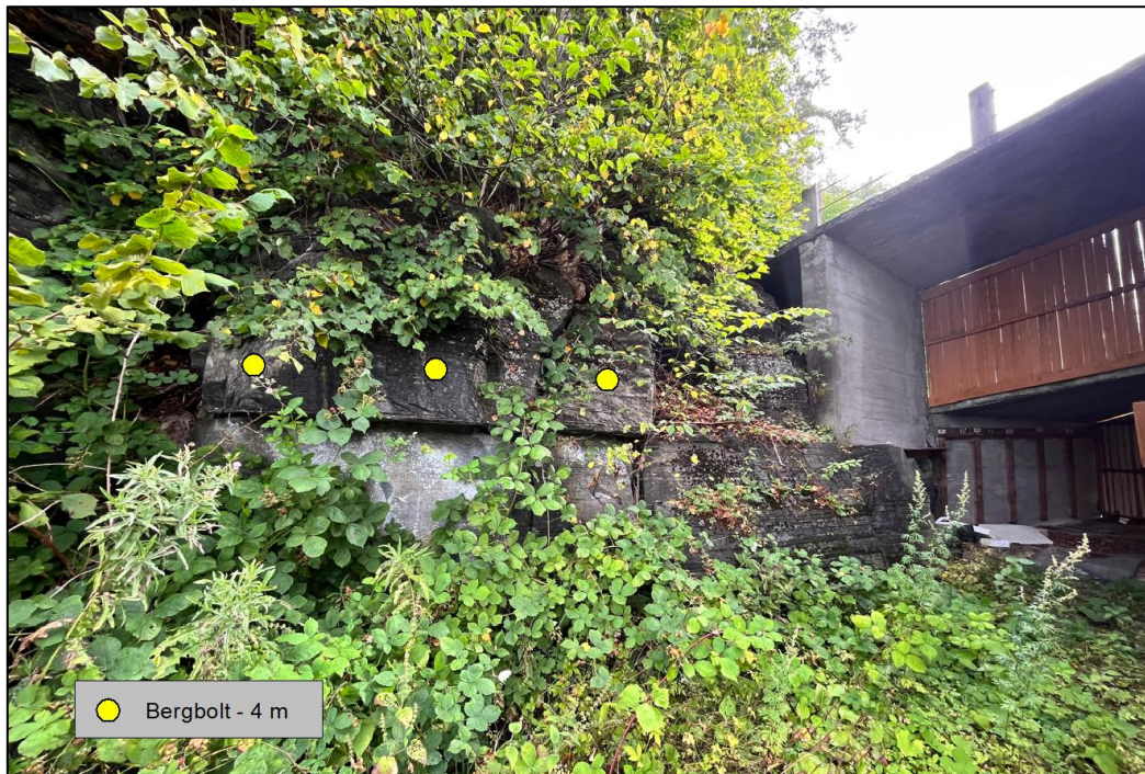
Figur 6. Sikring med bergbolter - fareområde nord.
