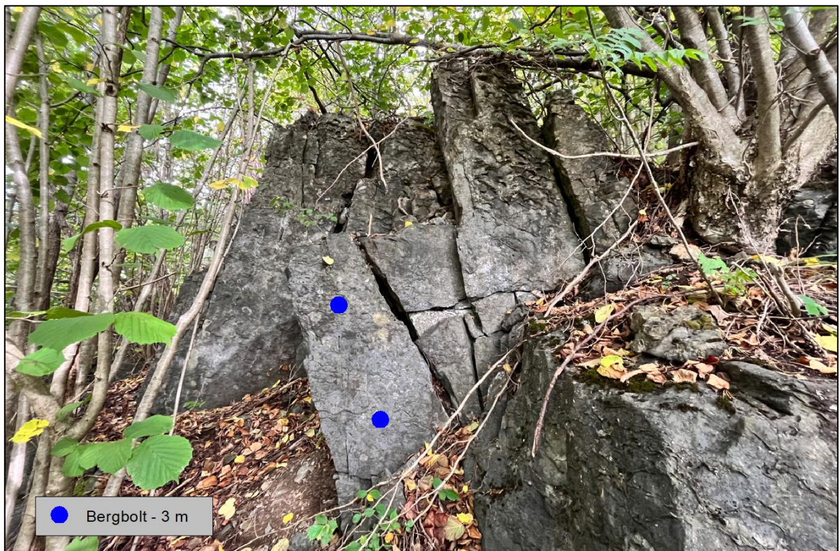
Figur 5. Sikring med bergbolter - fareområde nord.
