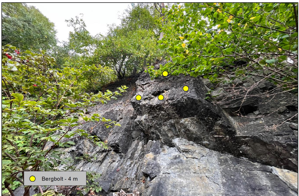
Figur 9. Sikring med bergbolter - fareområde sør.
