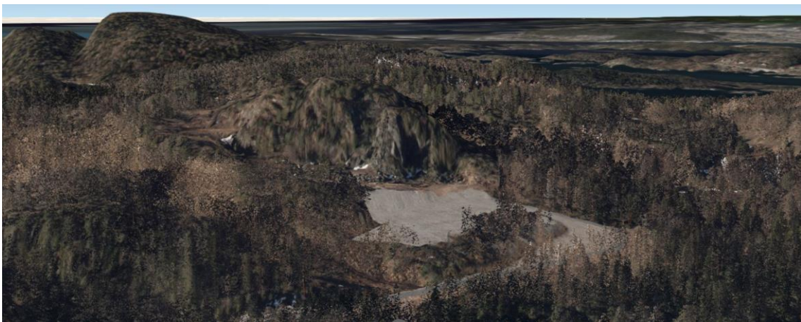
Figur 5 Bildet viser 1. etappe, der veg og driftsområdet er etablert.
