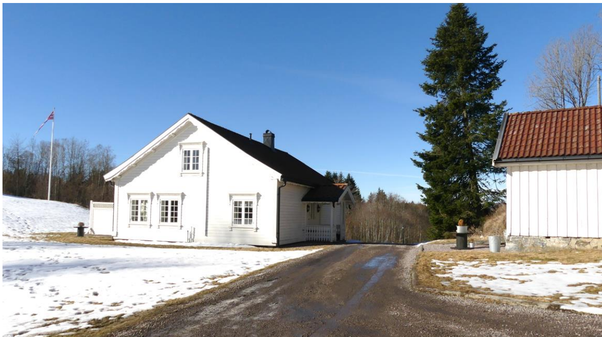
Figur 17. SEFRAK-objekt i kulturmiljø CH08. Våningshus ID 0805-0032-026 og bryggerhus 0805-0032-027. Tiltaket går 80 øst for tunet og i tunnel. Foto : Asplan Viak.
