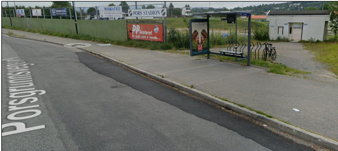
Figur 37 Busslomme på østsiden av veien, har venteeareal og taktil merking i midten av busslommen, noe som ikke er riktig iht. krav fra håndbøkene.
