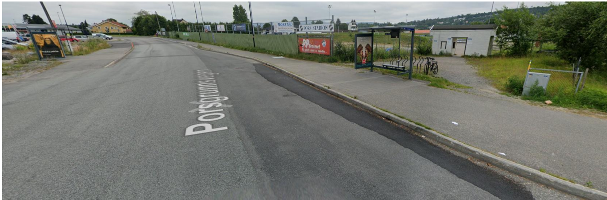
Figur 12 Bussholdeplassene «Pors stadion» sett fra sør. Holdeplassen er utformet som busslomme på østsiden av Porsgrunnsvegen og kantstopp på vestsiden av Porsgrunnsvegen, med tilhørende fortau og leskur. Bildet er hentet fra Google Maps.
