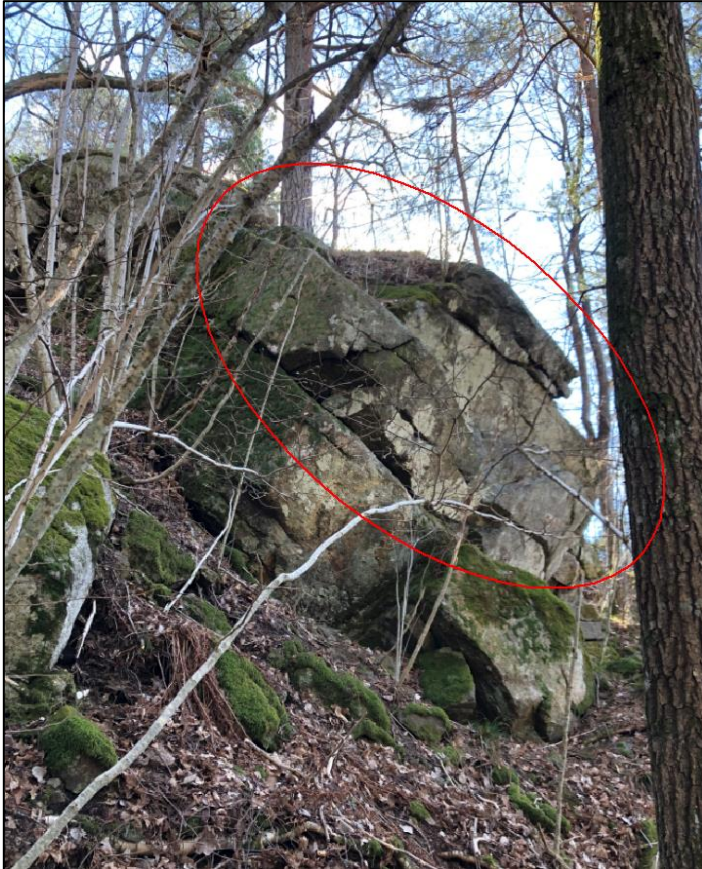
Figur 12. Avløste steinblokker som ligger an mot sprekker som faller steilt ut av skrenten.
