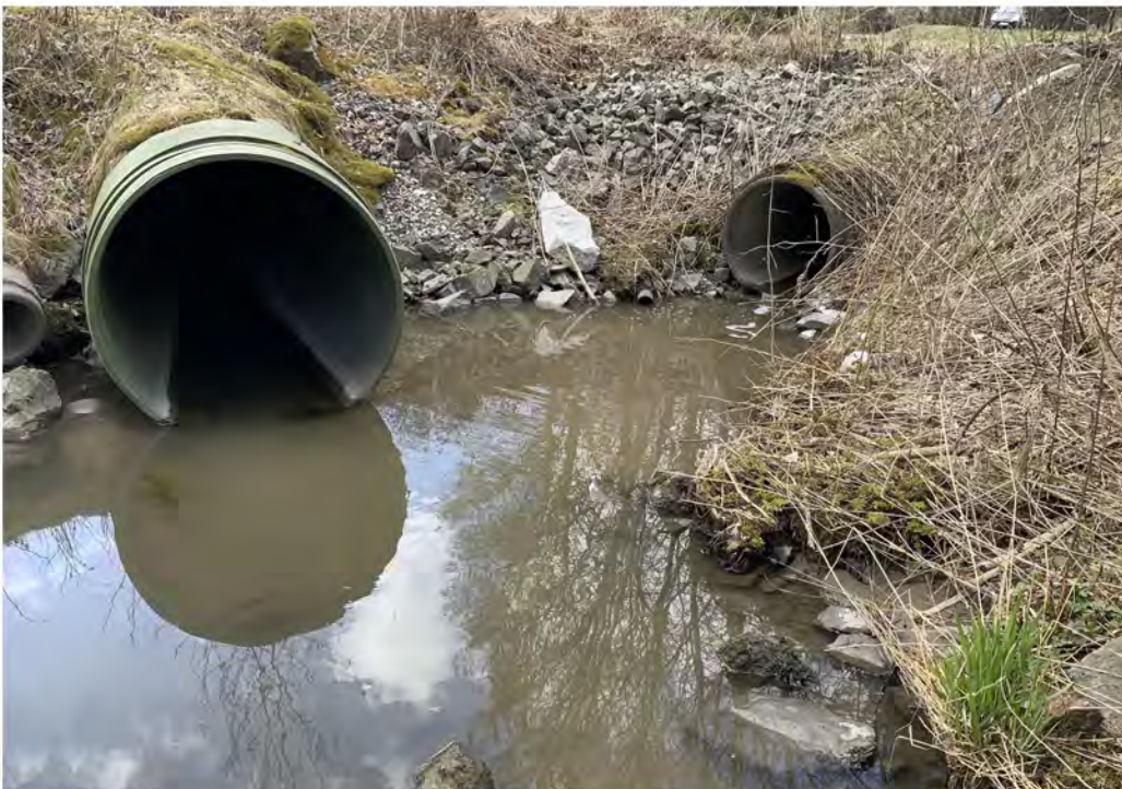
Figur 15. Utslipp av overvann fra vestre del av Moheim næringsområde kommer ut i rør til venstre, ca. 200m oppstrøms Herregårdsbekken. Bekken som drenerer under Porsgrunn utvikling AS kommer ut gjennom røret til høyre i figur (egen kartproduksjon)
