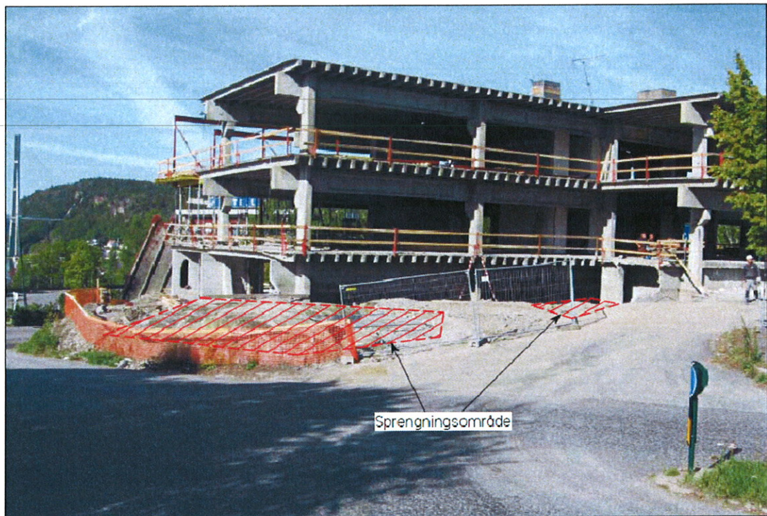
Bilde 1. Viser sprengningsområde (rød skravering) i dagen ved Korvetten Panorama. Rett under (10-12 m) sprengningsområdet ligger fjellhallene tilhørende Diplom-Is. Bildet er tatt mot nordvest.
