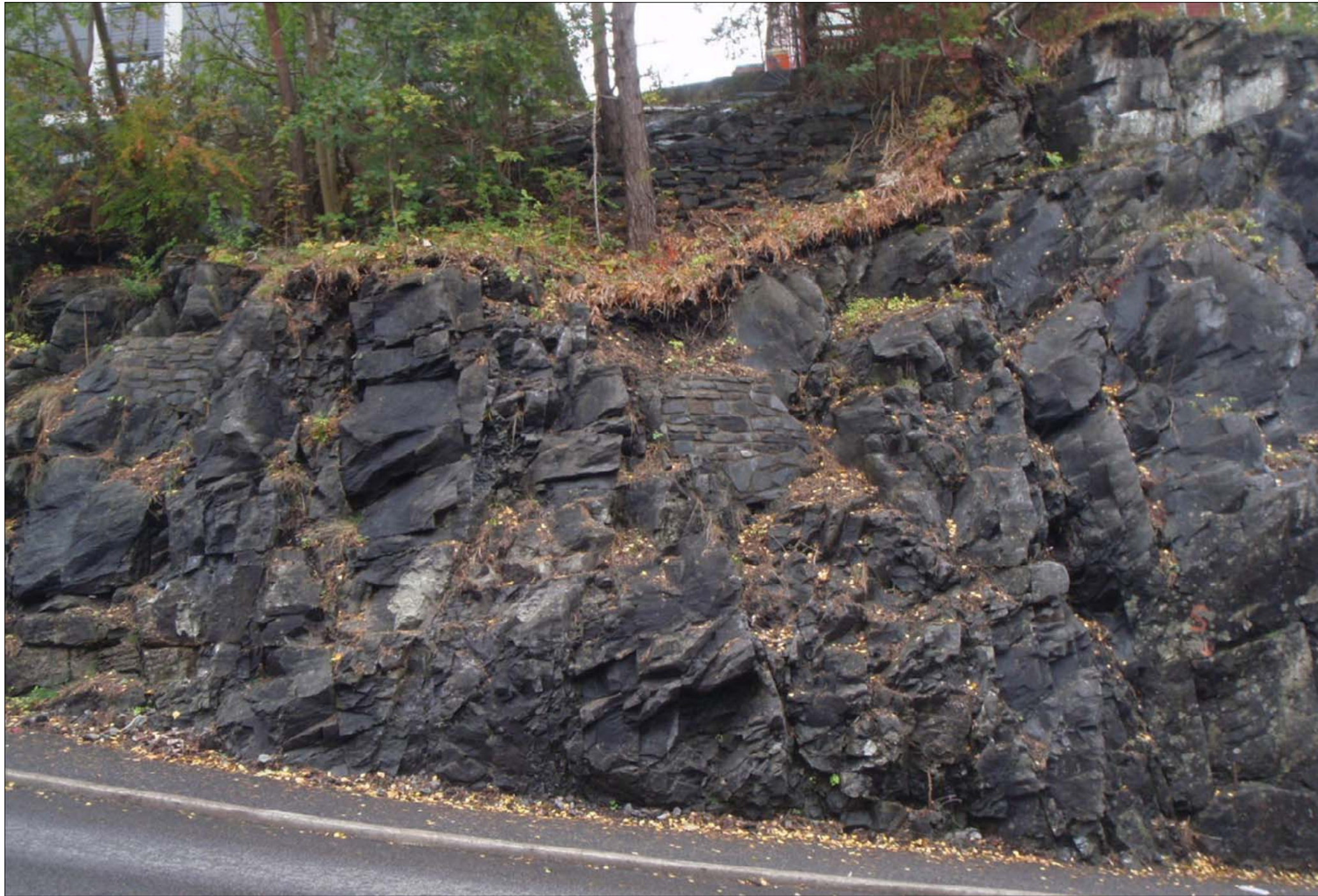
Bildet viser deler av veiskjæringen med småfallent berg helt nord i reguleringsområdet. Bildet er tatt mot syd.
