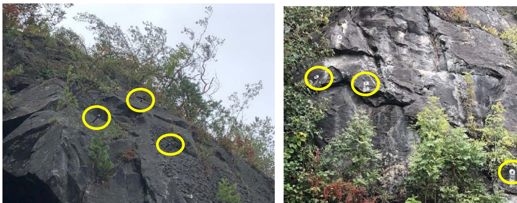
Figur 8. Eksisterende boltesikring i høy skjæring. I foto til venstre er det synlig innstøpte kamstålbolter uten skive (trolig eldst) og til høyre innstøpte bergbolter med skive (trolig av nyere dato). Foto Olav Bache-Hansen.
