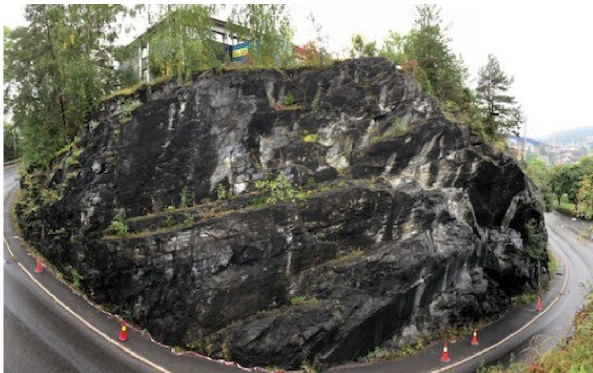
Figur 7. Panoramafoto av eks skjæring i innersving. Foto i østlig retning tatt fra Torskebergvegen 11. Det er massive kalksteinsbenker med svakt fall mot nordøst (venstre) og steile sprekker med fall inn i skjæringen. Foto tatt av arkitekt Olav Bache-Hansen
