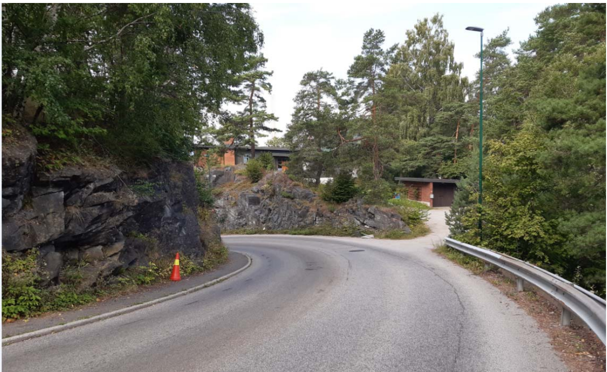
Figur 4. Foto mot innkjøring til Torskebergvegen 11. Behov for ny støttemur på utsiden av vegrekkverk. Det er mulig å etablere adkomst for anleggsmaskiner fra innkjøringen til nr 11 og tilbake langs foten av eksisterende mur. Anleggsarbeider i skråningen nedenfor bør ikke skje på vinterhalvåret pga. fare for utglidning og velting av maskiner.
