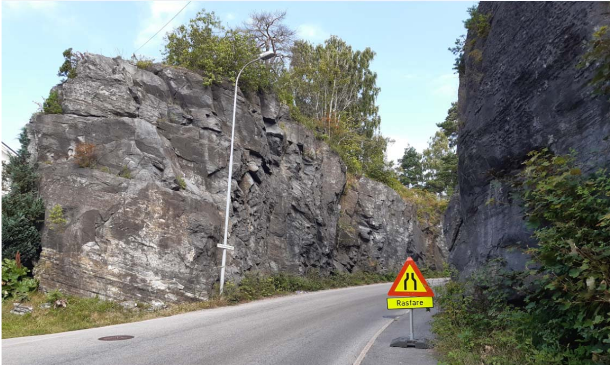
Figur 5. Foto opp Torskebergvegen. Legg merke til skilt «rasfare» i det smale fortauet. Berget i yttersvingen er mer oppsprukket enn i innersving. I venstre billedkant skimtes gavlvegg for tilbygg i Strømtangveien 10. Se også foto 13.
