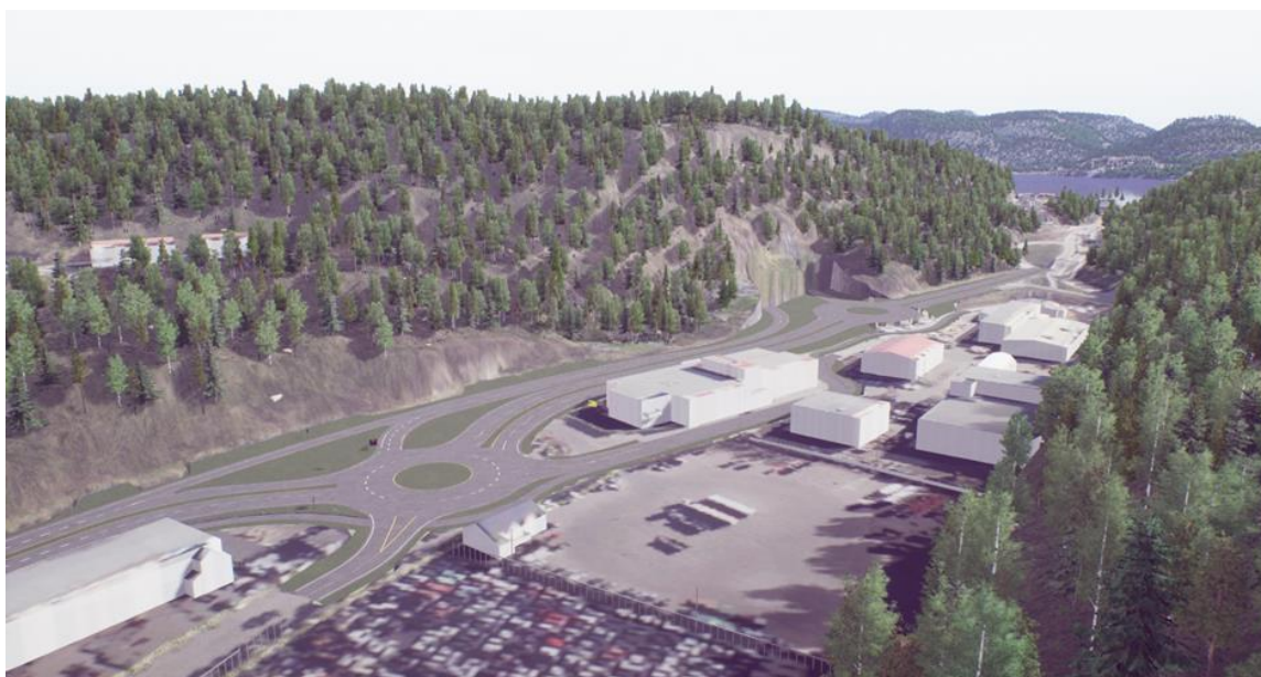
Figur 6-7 Portalene for tilkoblingen til E18 i tunnel er planlagt i eksisterende fjellskrent på nordsiden av dalen.
